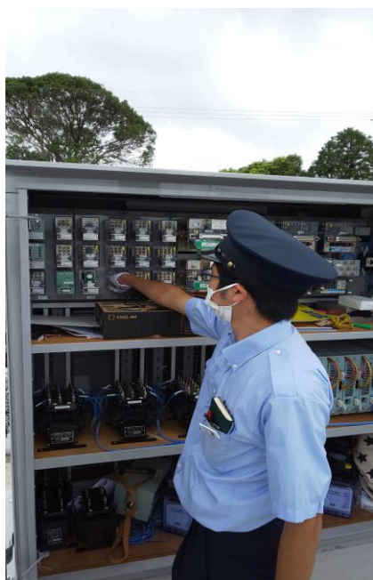
(踏切スイッチ確認作業風景)
